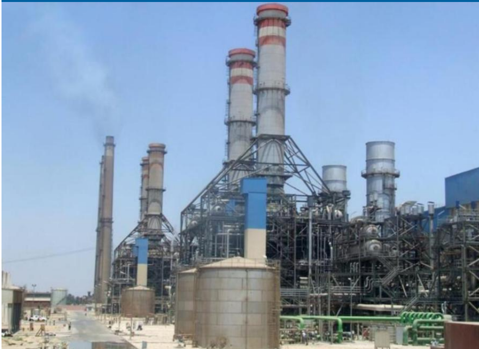
Электростанция Эль-Куреймат, Египет
